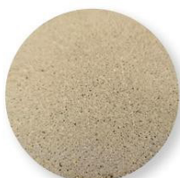
Núcleo de concreto carbonatado após a remoção da superfície calcária macia com uma esponja abrasiva.
