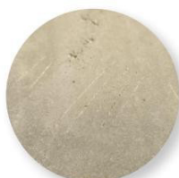
Núcleo de concreto carbonatado com superfície macia e calcária.
